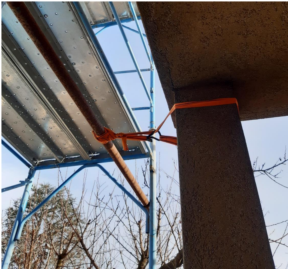
Dettaglio del sistema di ancoraggio non a norma
