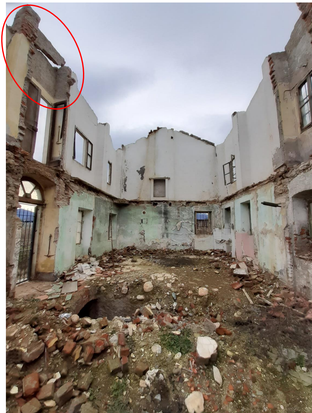
Vista interna del fabbricato con porzione pericolante
