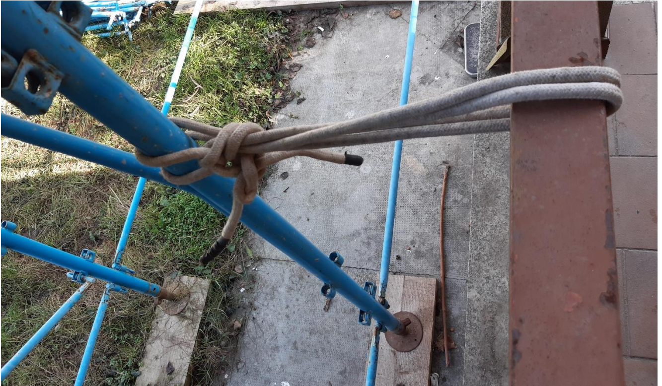
Dettaglio del sistema di ancoraggio non a norma
